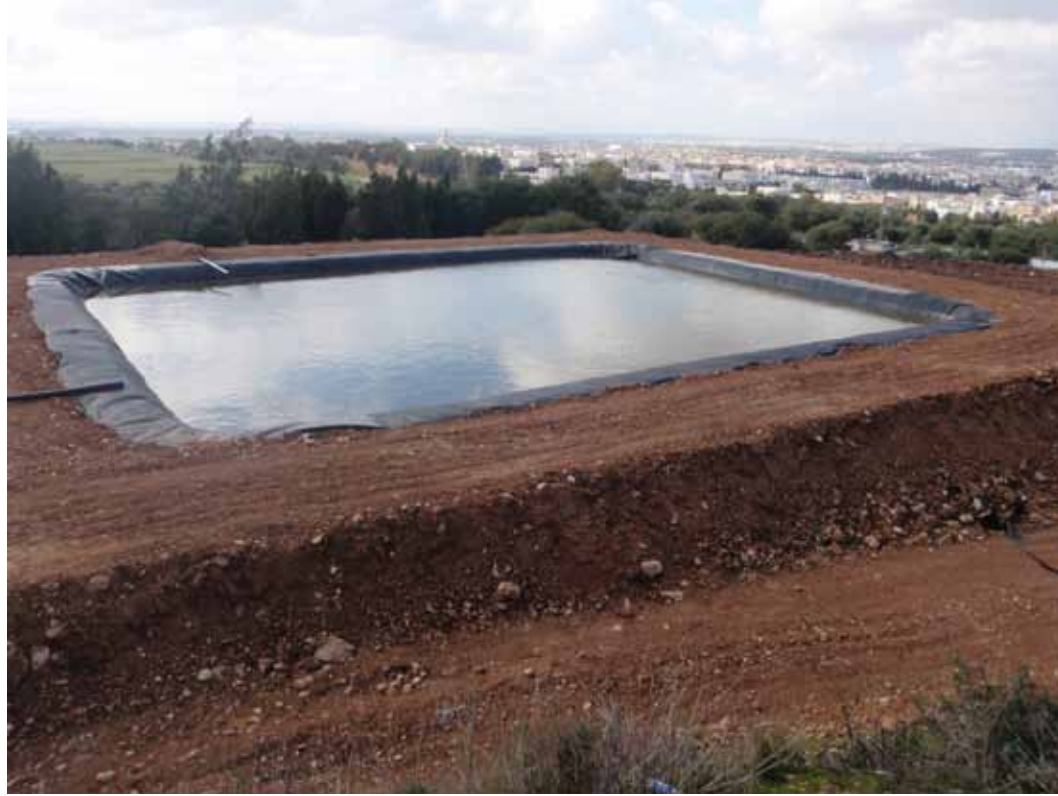
تهيئة حوض لترسيب المياه
