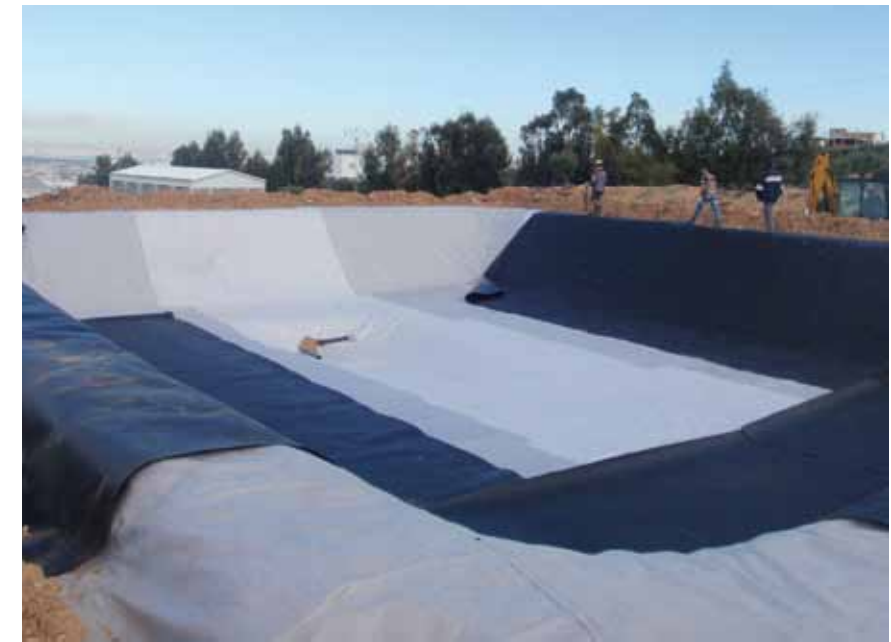
تهيئة حوض لترسيب المياه
