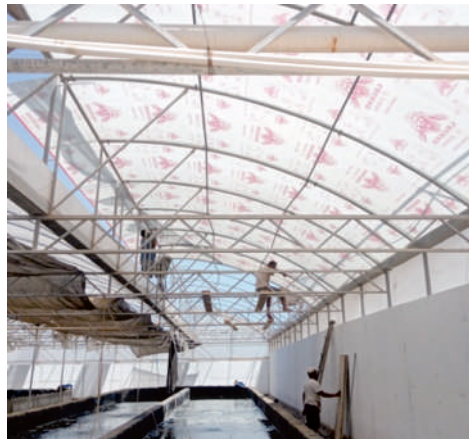
إنطلاق أشغال تهيئة الغلاف الخارجي للبيت المكيفة
